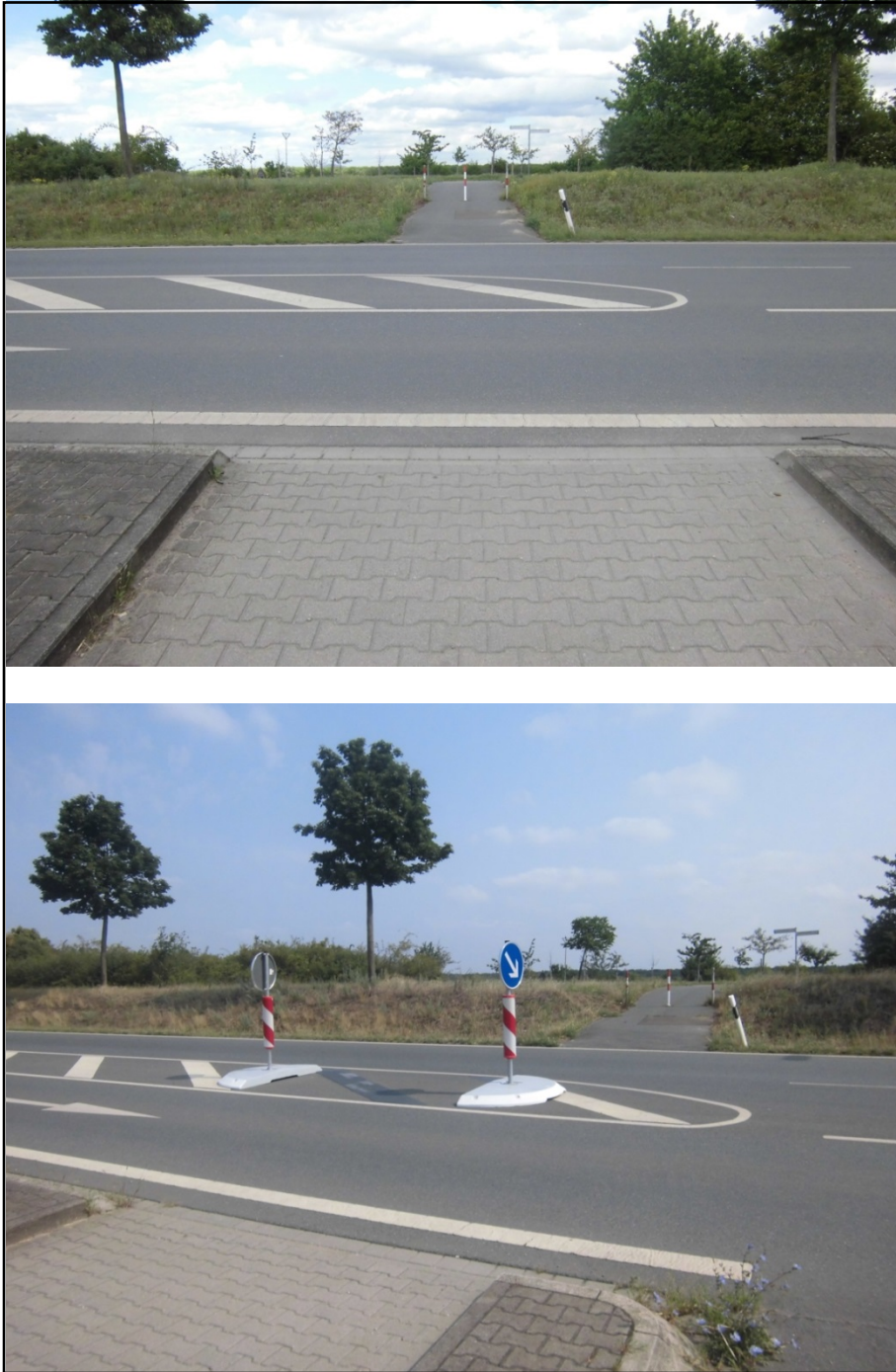
Abbildung 35: Überquerungsstelle Ostumgehung Höhe Dieselstraße (vorher – nachher) [10]
