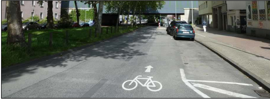
Abbildung 7: Markierung von Fahrrad-Piktogrammen zur Verdeutlichung der Aufhebung der Radwegebenutzungspflicht [9]
