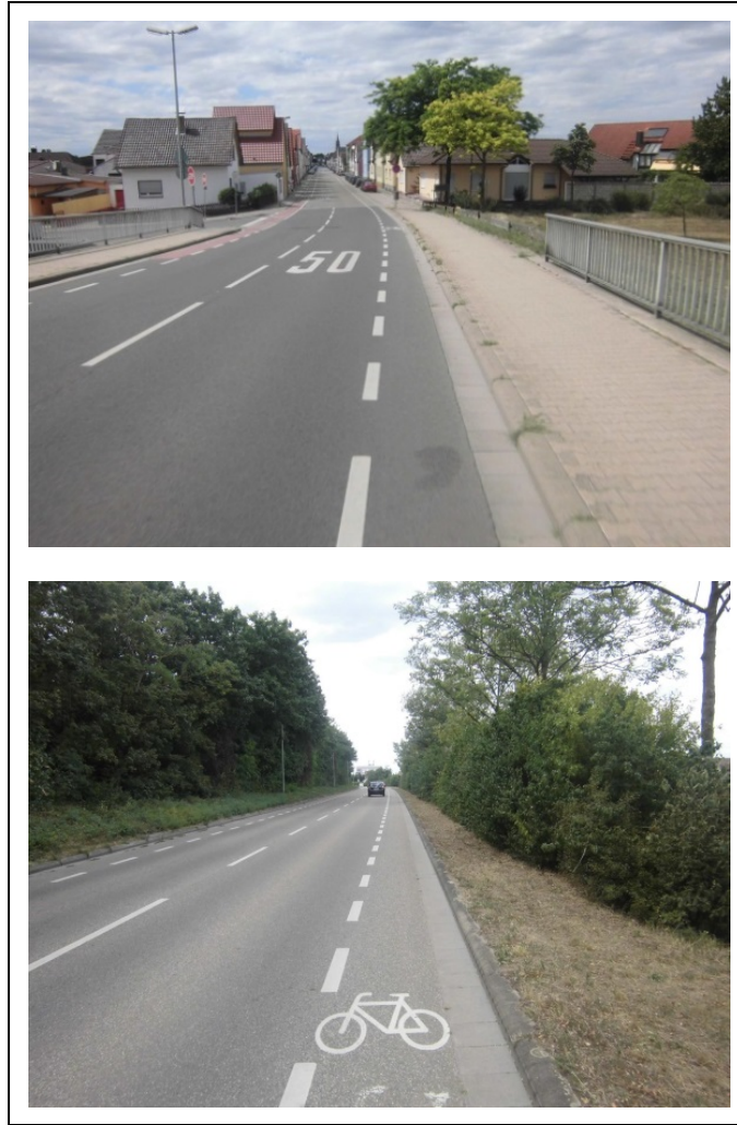
Abbildung 8: Schutzstreifen an innerörtlichen Hauptverkehrsstraßen [10]
