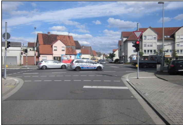
Abbildung 33: Fehlende Radverkehrsführung am Knotenpunkt (Blickrichtung aus An der Sandbeune) [10]
