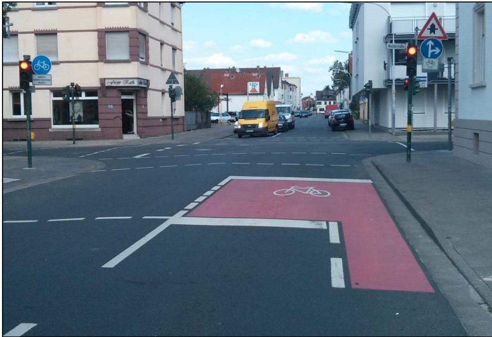
Abbildung 23: Aufstellfläche für Radverkehr an signalisiertem Knotenpunkt [6]
