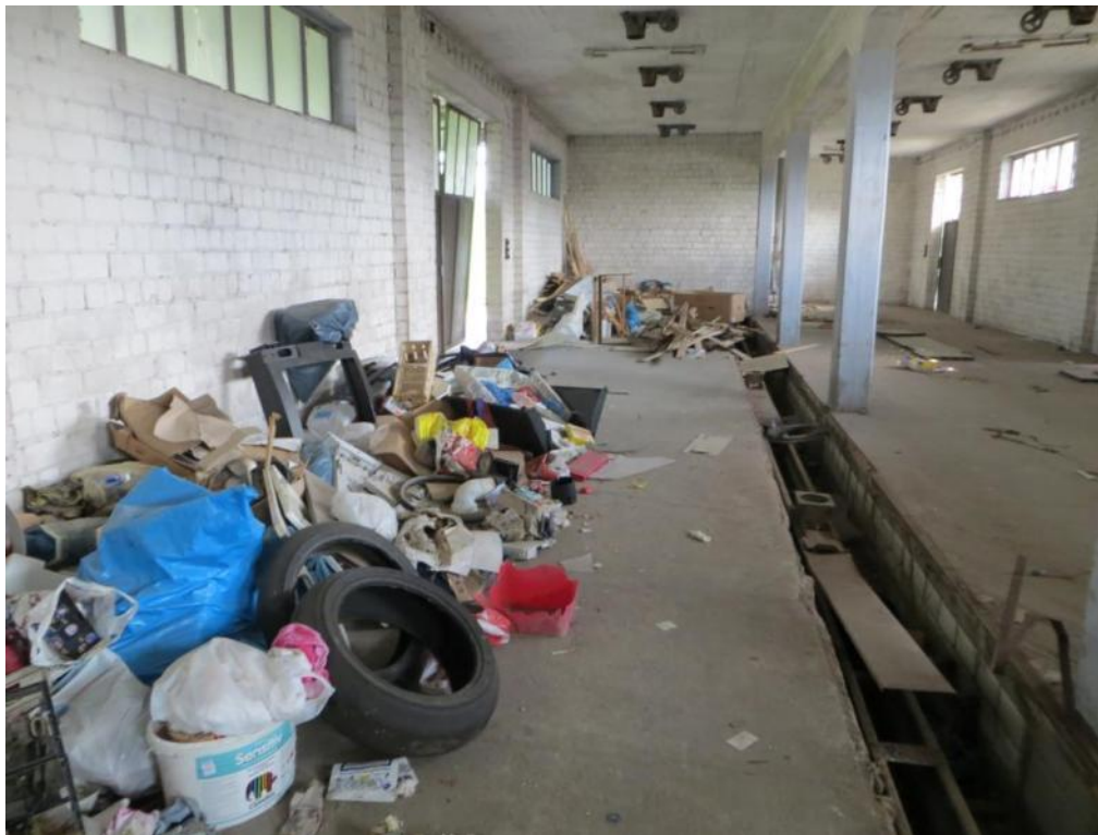
Foto 6: Innenbereich der Halle
